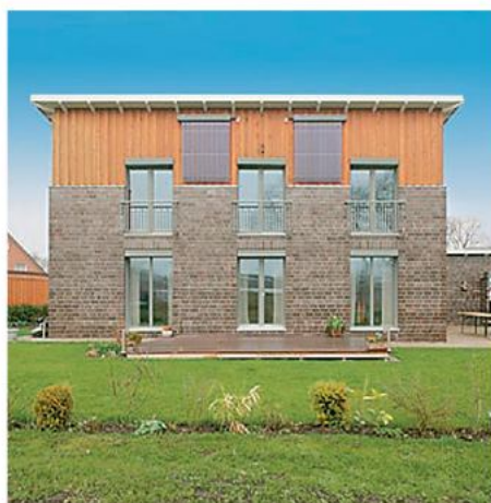
Kolektory słoneczne Vitosol 200-T powieszone pionowo na ścianie budynku.
